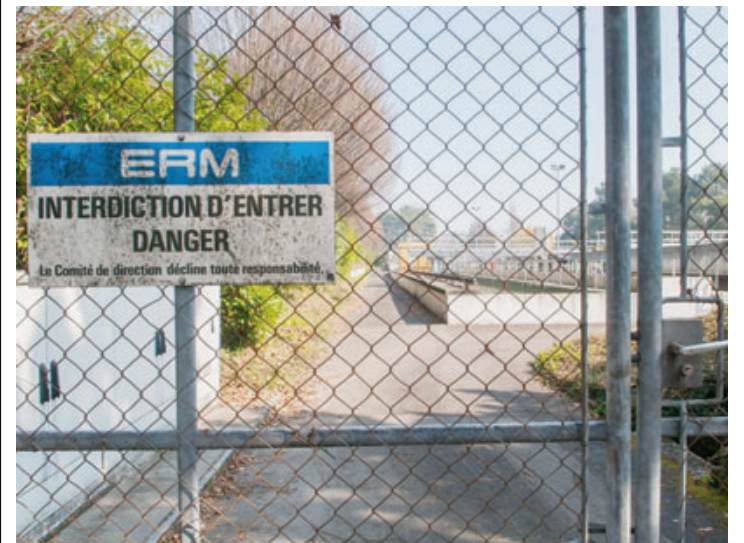
Inaccessible au public, la station d'épuration du Bief. L'ERM compte, pour rappel, 14 communes membres et 3 abonnés. CÉDRIC SANDOZ
