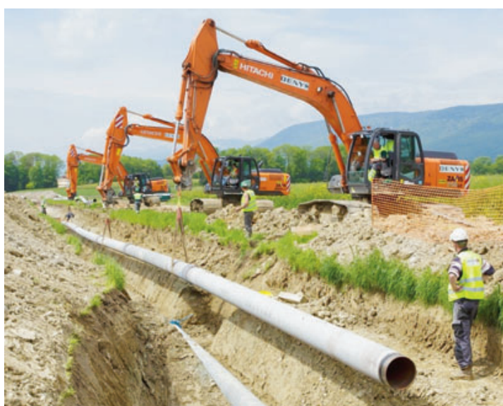
Le chantier a démarré le 1 er mars 2013, il a fallu une année tout juste pour que le gazoduc soit opérationnel. DR/GAZNAT
